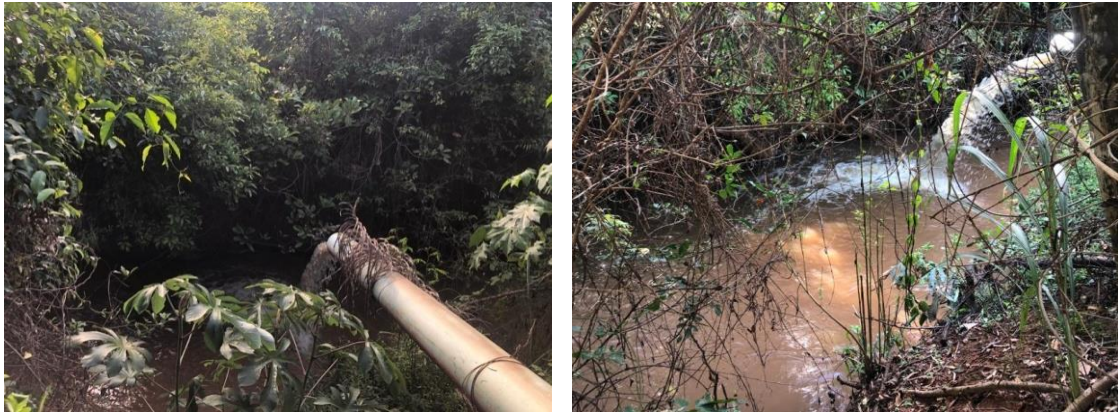
Figura 8. Ponto de lançamento do efluente final
