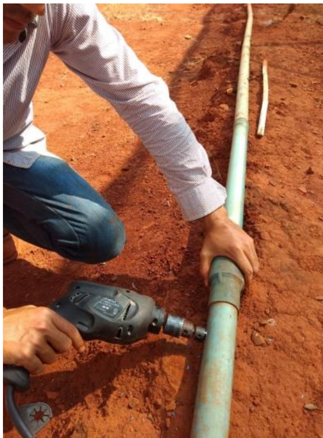
Figura 7. Montagem do sistema de irrigação. Fonte: Arquivo Pessoal (2019).
